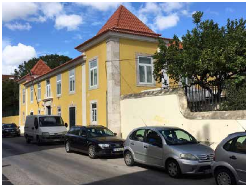
Fig. 5 – Edifício na Rua Nova do Calhariz 2-8. Fotografia de Tiago Molarinho Antunes.
