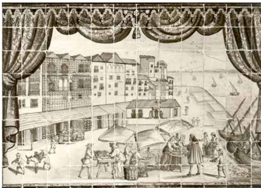
Fig. 5 - Vista da zona da Ribeira junto da Casa dos Bicos, mostrando as varandas desta casa assim como as da Casa dos Condes de Linhares entaipadas. Azulejos dos inícios do séc. XVIII. Museu da Cidade de Lisboa.
