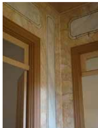
Ilustração 9 “Escaiolas” aplicadas nas superfícies parietais dos ambientes internos – corredores, hall de entrada e salas - e nos fustes das colunas da varanda.
