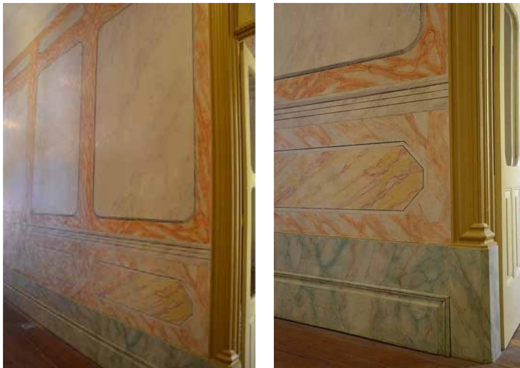
Ilustração 6 Revestimento parietal em marmorino/escaiola. Casarão Conselheiro Francisco Antunes Maciel, Pelotas. Fotos: Alexandre Mascarenhas, 2013.
