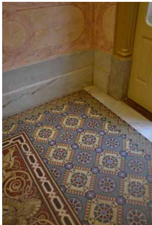
Ilustração 4 Estuque decorado em relevo e piso em ladrilho hidráulico decorado do Hall de entrada. Casarão Conselheiro Maciel, 1878, Pelotas, RS. Fotos: Alexandre Mascarenhas, 2013.
