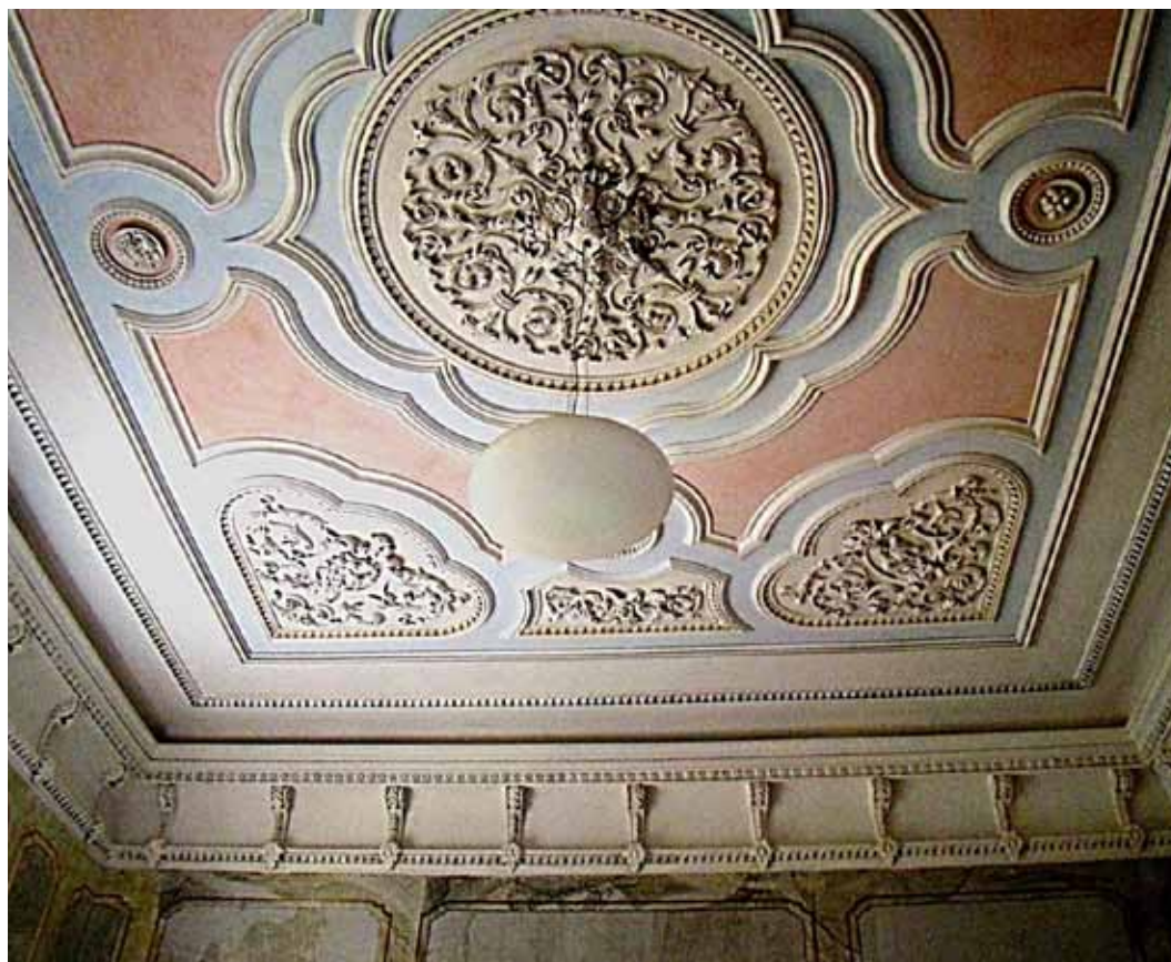
Ilustração 10 Vista geral do forro da Sala de Jantar e detalhes das ornamentações de canto em estuque em relevo. Fonte: fotos de Cristina Rozisky, 2012.
